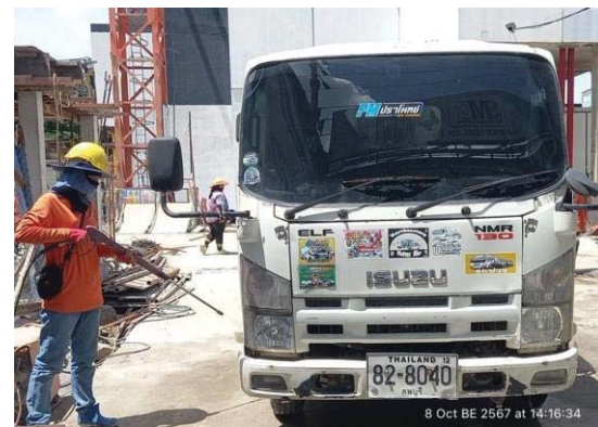
รูปที่ 3-10 คนงานทำความสะอาดล้อรถ ก่อนออกจากโครงการ
